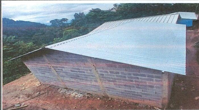
Foto 2: Instalación de cemento corrido de block
