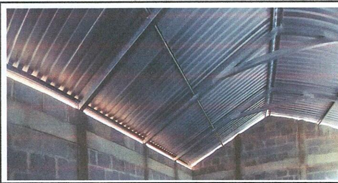
Foto 5: Instalación de estructura de techo y cubierta de láminas calibre 26
